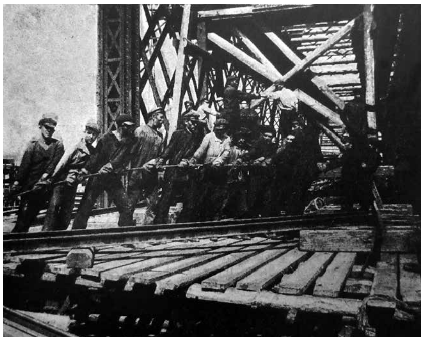
Будівництво декорацій до фільму «Звенигора»
