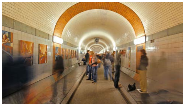
Іл. 4. Тунель під річкою Ельба (Elbe Tunnel) (Гамбург). [11]
