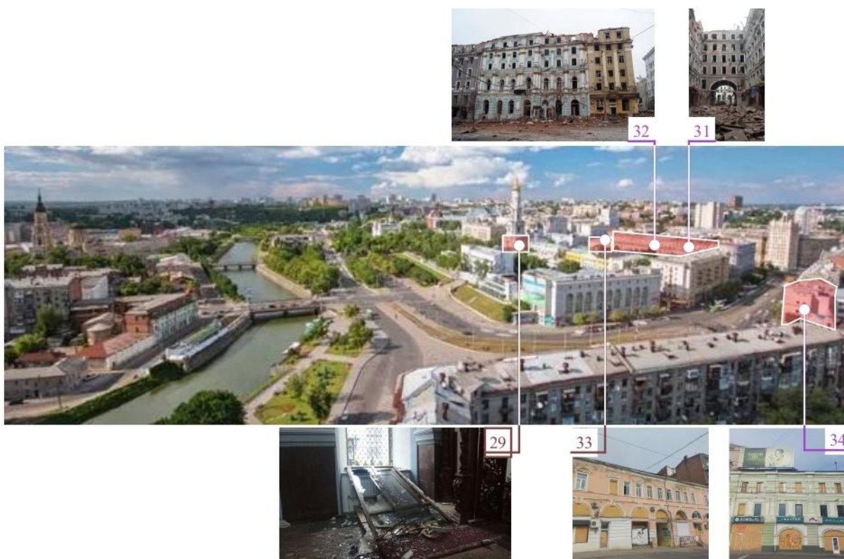
Рис. 3.12. Панорамний вигляд2 Харкова із зазначеними руйнуваннями забудови
