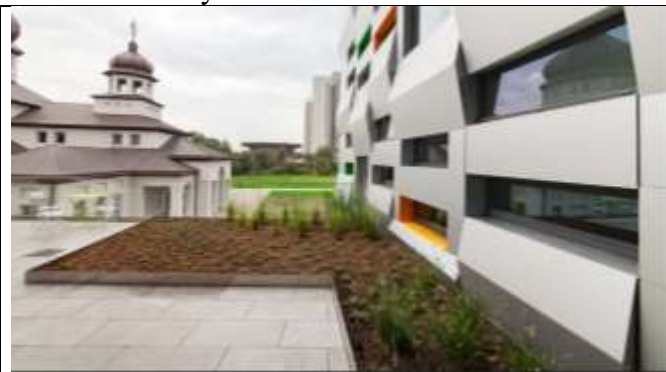
Рис. 101. Експлуатована поверхня другого поверху Центру ім. А. Шептицького
