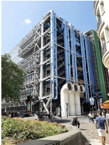
а) Будівлі із зовнішнім несним каркасом. Centre Georges-Pompidou (Франція) [©Bernhard G; ©Renzo Piano Building Workshop, Richard Rogers]
