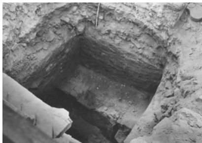
Іл. 5. Шурф реставраторів. Частина відкритого фундаменту на відмітці - 3,1 м. 1980
