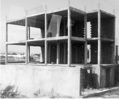
Іл. 3. Малоповерховий каркасний житловий будинок у процесі спорудження
