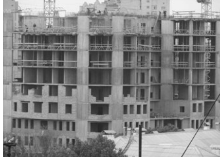
Іл. 4. Житловий багатоповерховий будинок у процесі спорудження
