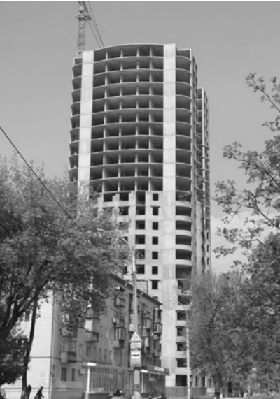
Іл. 5. Будинок підвищеної поверховості на стадії завершення будівельно-монтажних робіт
