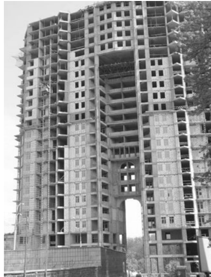
Іл. 6. Будинок з аркою з монолітним залізобетонним каркасом на стадії завершення будівельно-монтажних робіт
