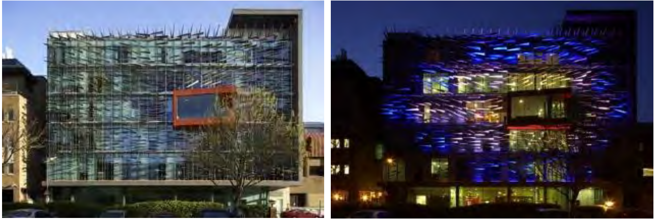
Рис. 4.58. Підсвічування фасаду можна вважати Moorfields Eye Hospital в історичному центрі Лондона
