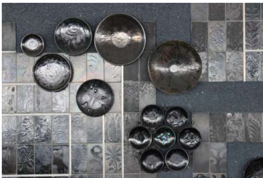
Б.3.51. Арх. З. Чечик, Ф. Боровик, С. Ходик, І. Онищенко, худ. Л. Мешкова, Н. Федорова, Г. Шарай, Я. Падалка. Будинок кіно. 1973–1975. Кераміка, стандартна розписна облицювальна плитка, тарелі. Штампування, гончарне коло, керамічні надглазурні фарби, глазури, розчинені солі кольорових металів, розпис. Загальний розмір панно 32,2 × 2,81 м (36 м 2 ); Ø тарелей: 18,5–48 см; модуль 14,5 × 26 см. Вул. Саксаганського, 6/8. Київ.
