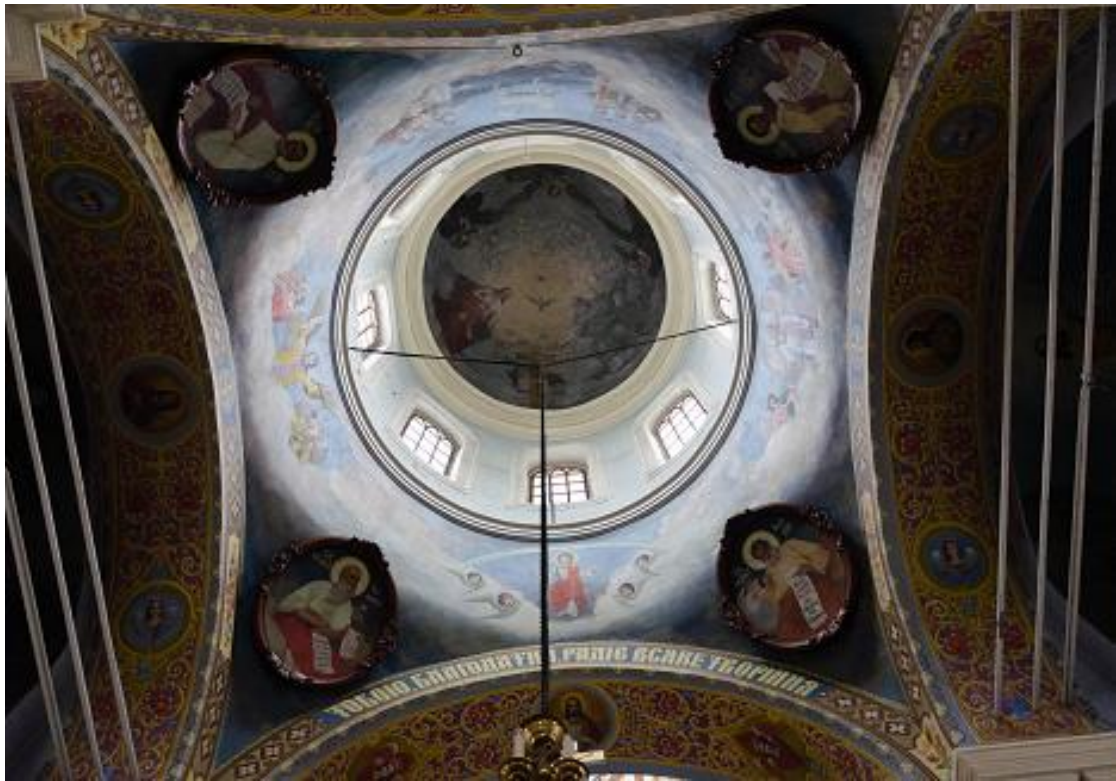
134. Центральний купол. Підпружні арки та підбанний простір. 2022. Києво-Подільська Покровська церква.
