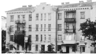
Реконструкція житлового будинку в Києві на Червоноармійській 160, нині 126 (1941 р.) А. В. Добровольський, В. О. Осмак
