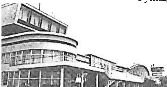
Аеровокзал Бориспіль в м. Києві А. В. Добровольський, О. І. Малиновський, Ю. Р. Євреїнов, Д. П. Попенко та ін. 1961-1965 рр.
