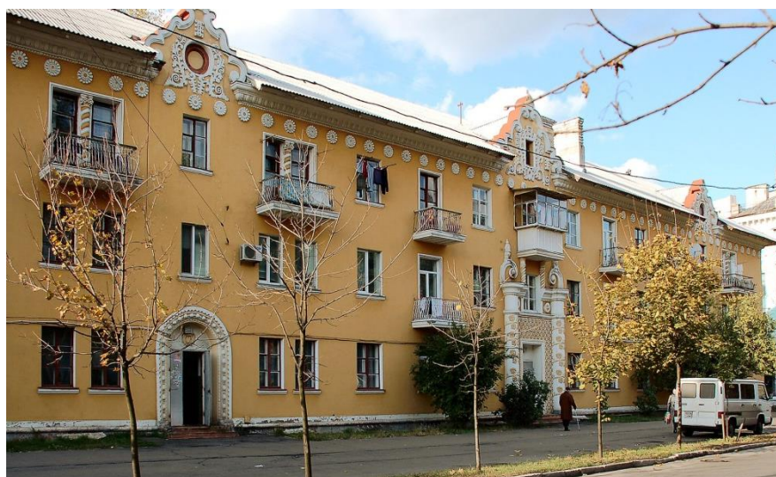
8. Київ, житловий будинок по вул Алма-Атинська , 101 проект -302-3 Державні архітектурні майстерні м. Києва арх. А. В. Добровольський
