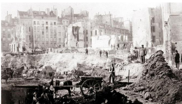
Рис. 3.02. Будівництво набережної Сени та прокладання нових вулиць та міських інженерних комунікацій у Парижі в другій половині ХІХ ст.
