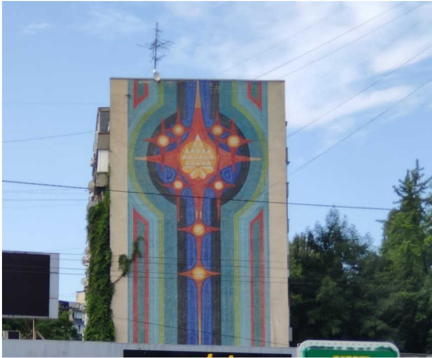
Іл. 3.10. В. Прядка.. Мозаїка на фасаді житлового будинку на проспекті Перемоги, 25. 1978 р.
