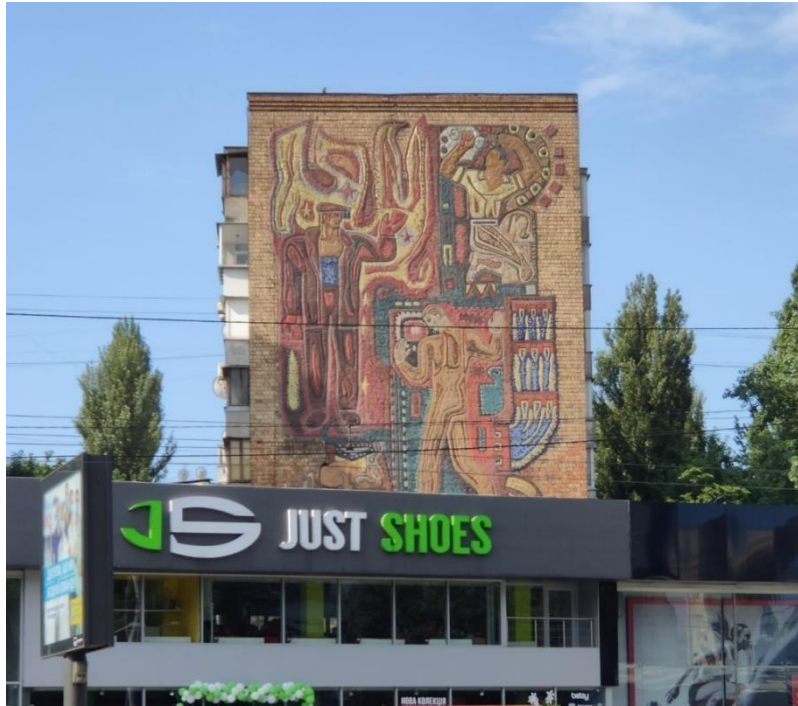
Іл. 2.63. В. Ламах, Е. Котков. Мозаїка «Симфонія праці» на торці житлового будинку на проспекті Перемоги № 21, 1967 р.
