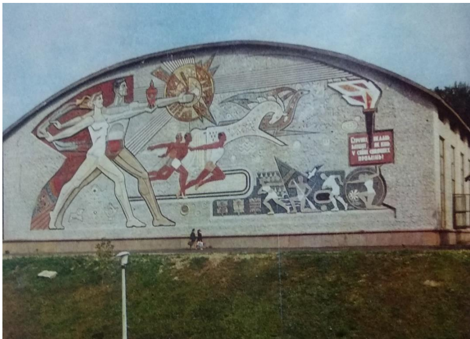
Іл. 1.10. А. Чернов за участі Е. Роганової, Л. Кулагіної. Панно «Радянський спорт» на торці будівлі тенісних кортів Центрального стадіону, 1964–1967 рр.
