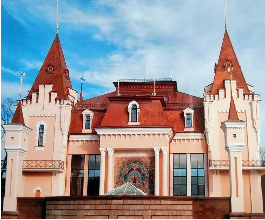
Іл. 2.4. Л. Фейнберг. Мозаїка на фасаді кінотеатру «Дніпро» (нині будівля реконструйована під Київський академічний театр ляльок), 1936–1937 рр.
