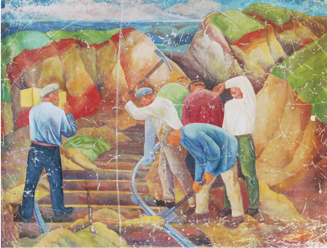
Іл. 3.4.36. М. Юнак. Прокладка колій. 1929 р.
