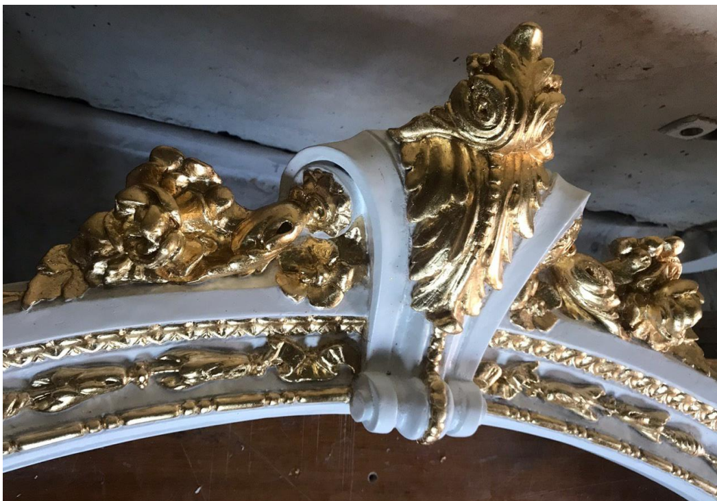
Лл. 23. Фрагмент віконного карнизу «Білої зали» після реставрації.
