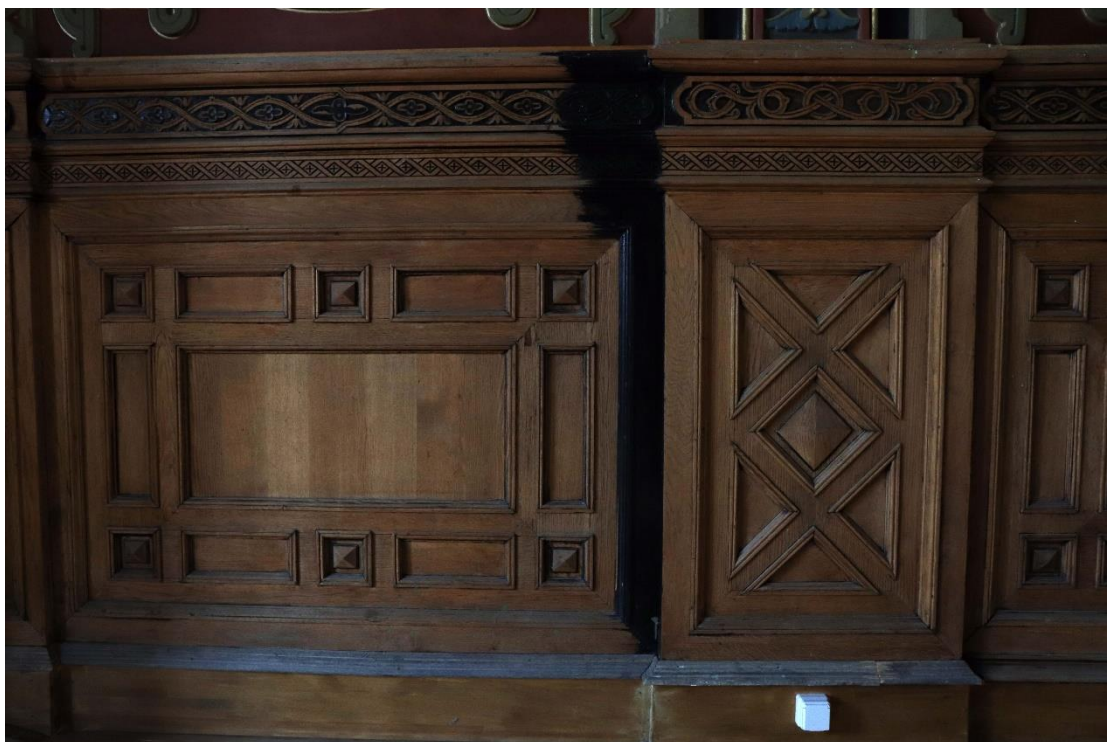
Іл. 30. Дерев'яні панелі в процесі розчисток від пізньої фарби - чорної пентафталевої емалі. (Світлина автора 2018 року)
