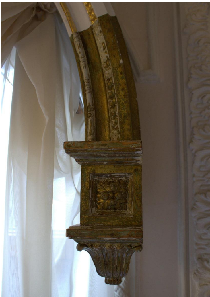
Лл. 24. Фрагмент первинного фарбового шару та золочення віконного карнизу «Білої зали».
