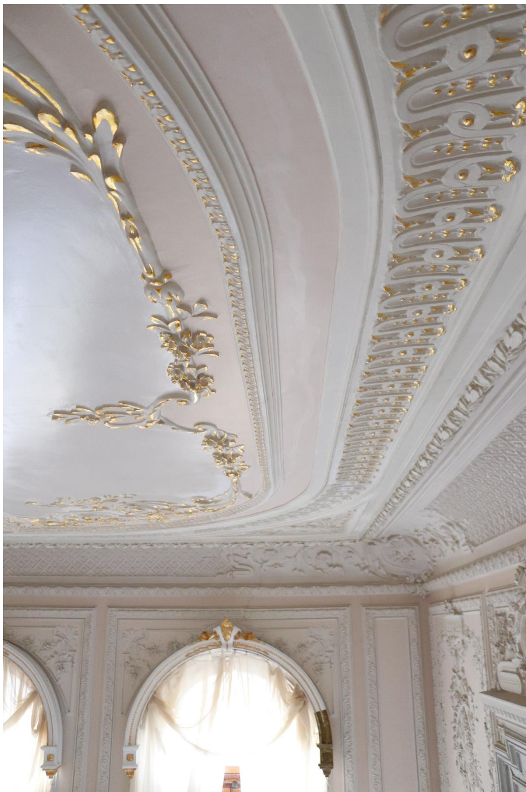
Іл. 26. Фотофіксація після реставрації тріщини на стелі «Білої зали».
