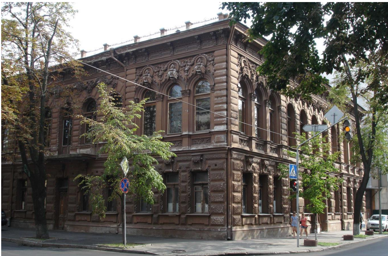
Іл. 1. Будинок по вулиці Шовковичній, 17/2. Загальний вигляд. (2010) [3]
