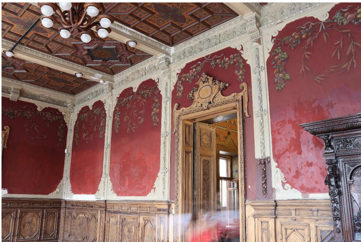
Іл. 10. Велика вітальня. До реставрації «гранатових» стін та реконструкції фарбового шару гіпсової ліпнини – пілястр. (Світлина автора 2021 року)
