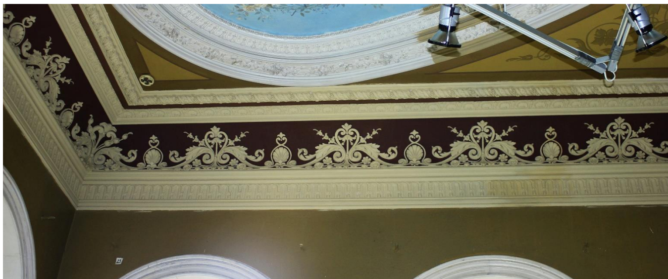
Іл. 36. Мала вітальня. Фотофіксація фризу після реставрації.
