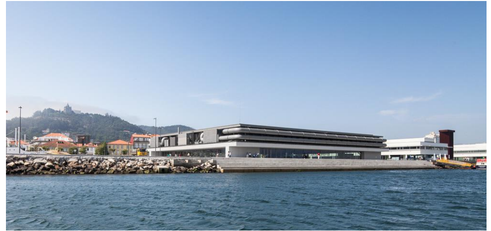
2.3, Іл. 22-23. Культурний центр Віана-ду-Каштелу архітектора Едуардо Соуто де Моура. Вигляд ззовні
