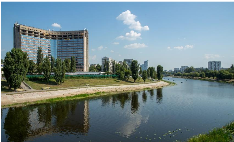
2.1, Іл. 21. Укріплений схил набережної
